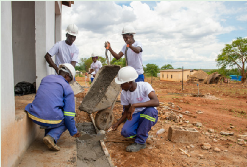
▲ Bauarbeitende beim Bauen eines neuen Wohnheims für Pflegestudent:innen in Kabwe. zb
